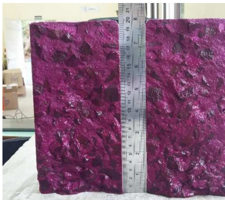
Figura 6. Ensaio de Carbonatação em RE4.
